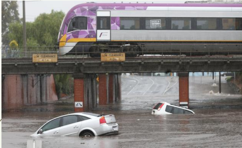
Actual flood inundation level \approx 1.46m
